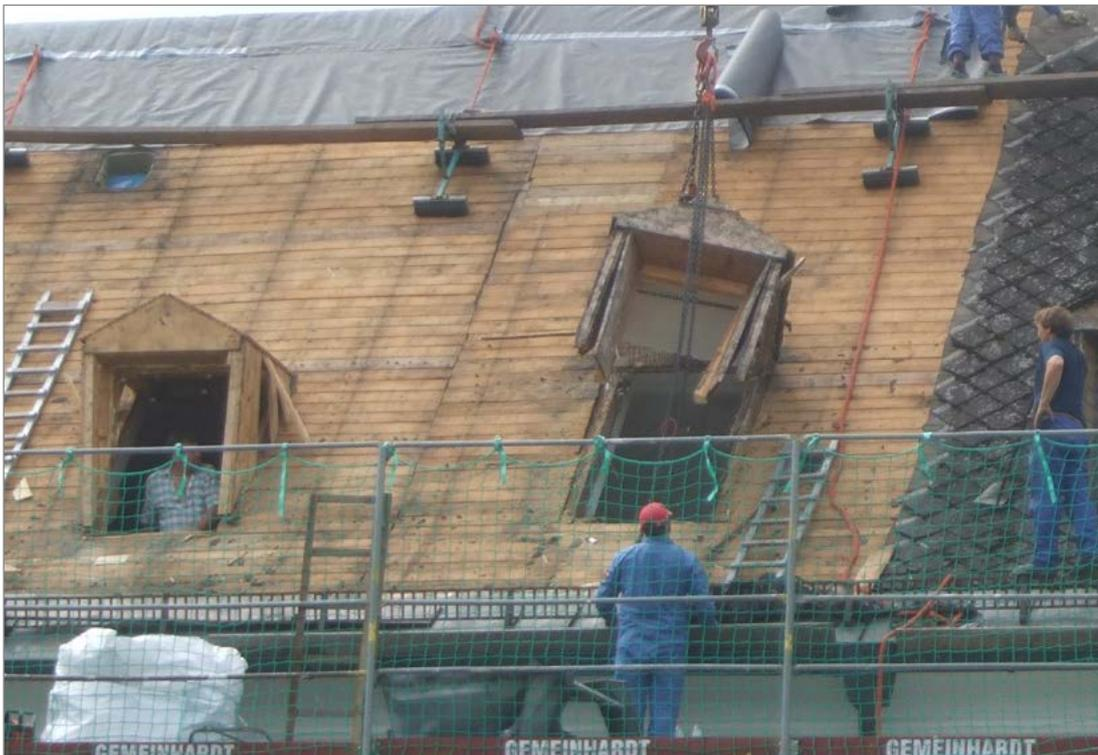
Verschrauben der Fußbohlen mit dem Bestandsdach.
