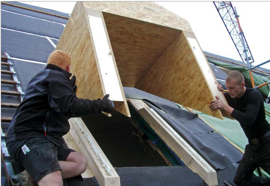
Ausrichten der Gaube und Verschrauben der Holzwerkstoffplatte mit der Fußbohle
