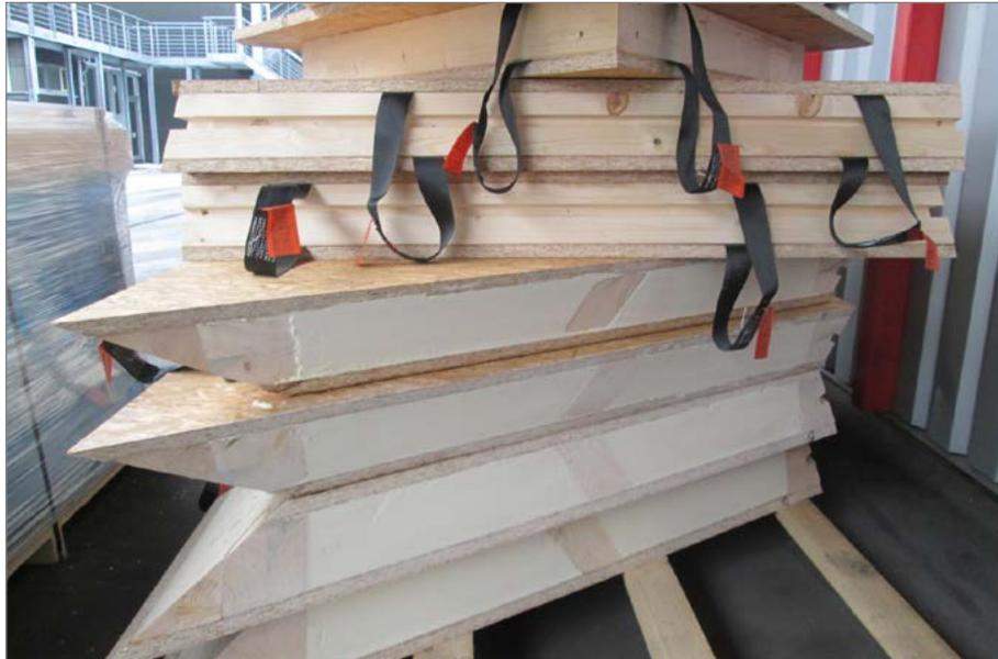
Die Schlaufen werden nach dem Aufrichten der Gaube abgeschnitten
