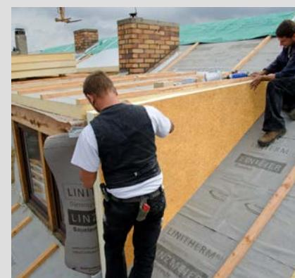
**Schnitt LITEC GBS – sichtbarer Dachstuhl mit Aufsparrendämmung**
