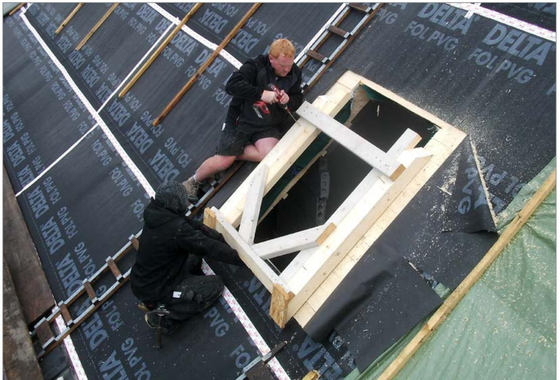
Fertig montierte Gaube wird auf die Fußbohlen gesetzt
